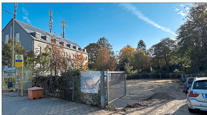
Das Gebäude entsteht an der Kreuzung Augsburgur Straße/Ludwig-Thoma-Straße.
